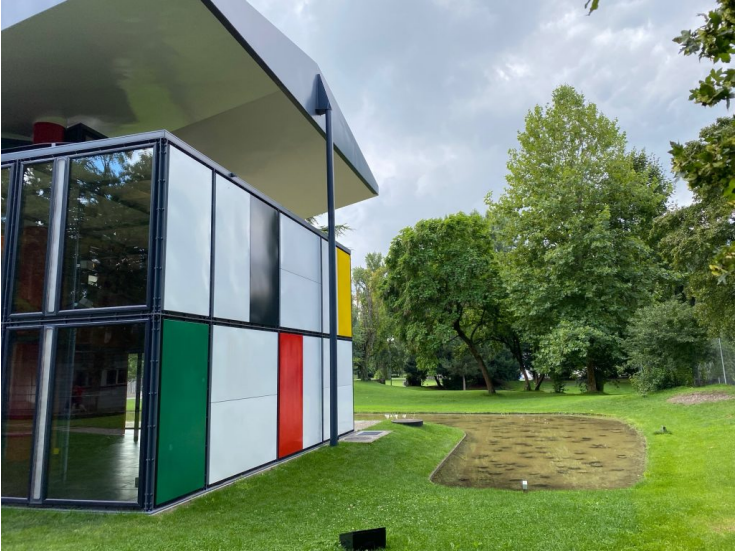
Le Corbusier house Zurich 2023
